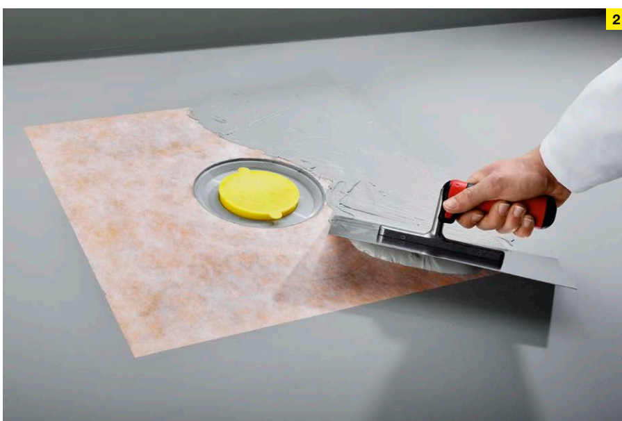
Нанесение 2-го слоя уплотнения с помощью проверенного в рамках строительной практики двухкомпонентного состава из пластика и цементного раствора.
